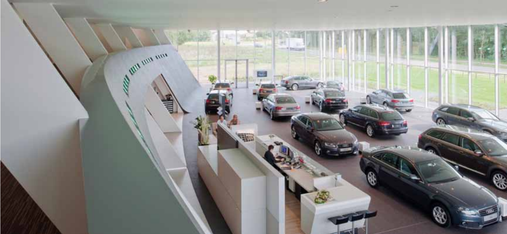
De gebogen wand onder de hoek van 60° is één van de blikvangers in de showroom. Hij bezorgde het bouwteam ook heel wat kopbrekens voor een kwalitatieve uitvoering.
